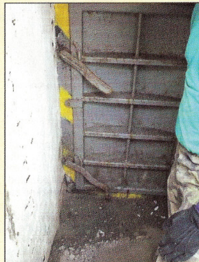
Obr. 2. Protitlakové dvere bunkra už za vstupným schodištom
